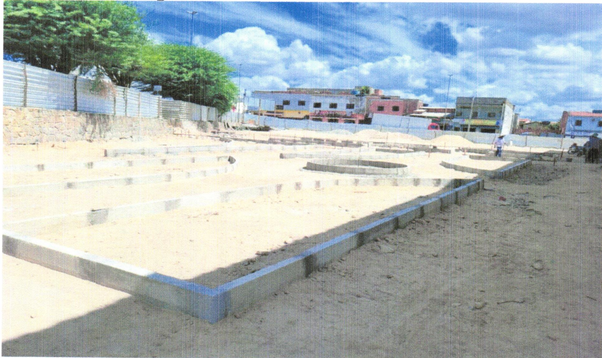
FOTO 68 - GUIA (MEIO-FIO) CONCRETO, MOLDADA IN LOCO EM TRECHO RETO COM EXTRUSORA, 15 CM BASE X 30 CM ALTURA. AF_06/2016
