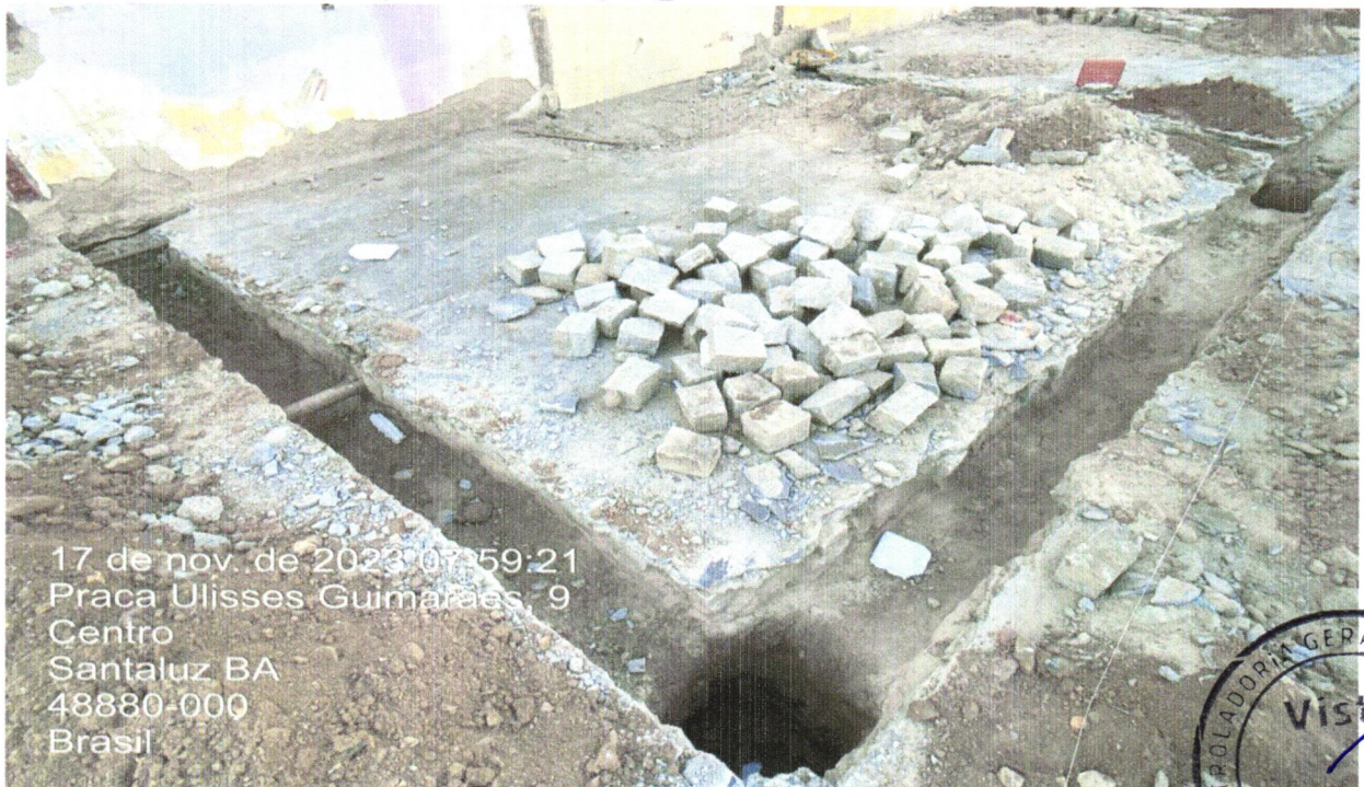
FOTO 14 - ESCAVAÇÃO MECANIZADA PARA VIGA BALDRAME COM MINI-ESCAVADEIRA (INCLUINDO ESCAVAÇÃO PARA COLOCAÇÃO DE FÔRMAS). AF_06/2017
