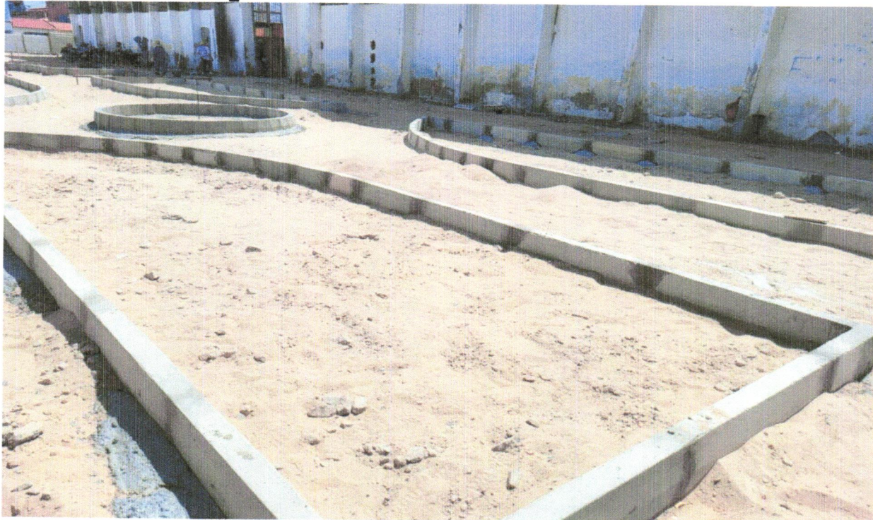
FOTO 70 - GUIA (MEIO-FIO) CONCRETO, MOLDADA IN LOCO EM TRECHO RETO COM EXTRUSORA, 15 CM BASE X 30 CM ALTURA. AF_06/2016
