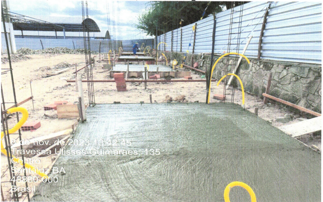
FOTO 60 - (COMPOSIÇÃO REPRESENTATIVA) EXECUÇÃO DE ESTRUTURAS DE CONCRETO ARMADO, PARA EDIFICAÇÃO INSTITUCIONAL TÉRREA, FCK = 25MPa. AF_01/2017.
