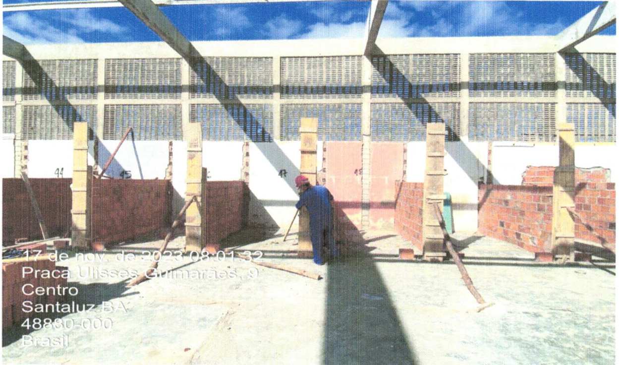
FOTO 22 - (COMPOSIÇÃO REPRESENTATIVA) EXECUÇÃO DE ESTRUTURAS DE CONCRETO ARMADO, PARA EDIFICAÇÃO INSTITUCIONAL TÉRREA, FCK = 25 MPA. AF_01/2017
