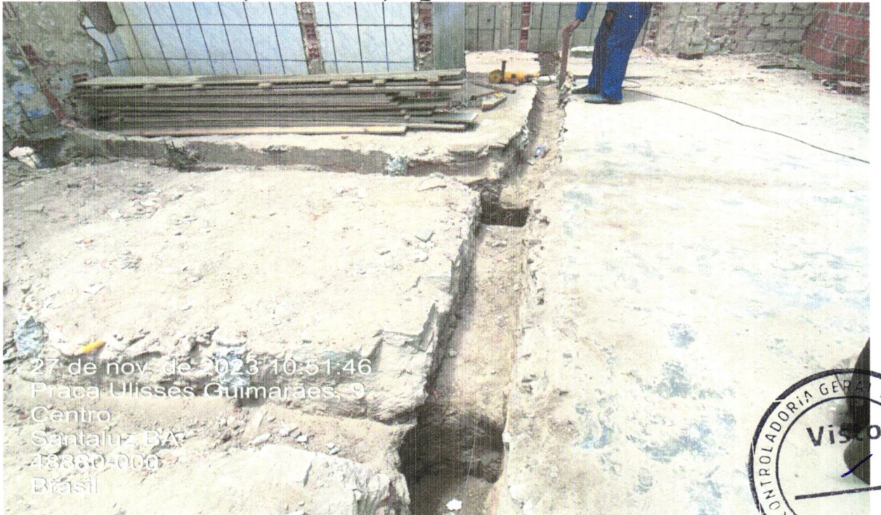
FOTO 12 - ESCAVAÇÃO MECANIZADA PARA VIGA BALDRAME COM MINI-ESCAVADEIRA (INCLUINDO ESCAVAÇÃO PARA COLOCAÇÃO DE FÔRMAS). AF_06/2017
