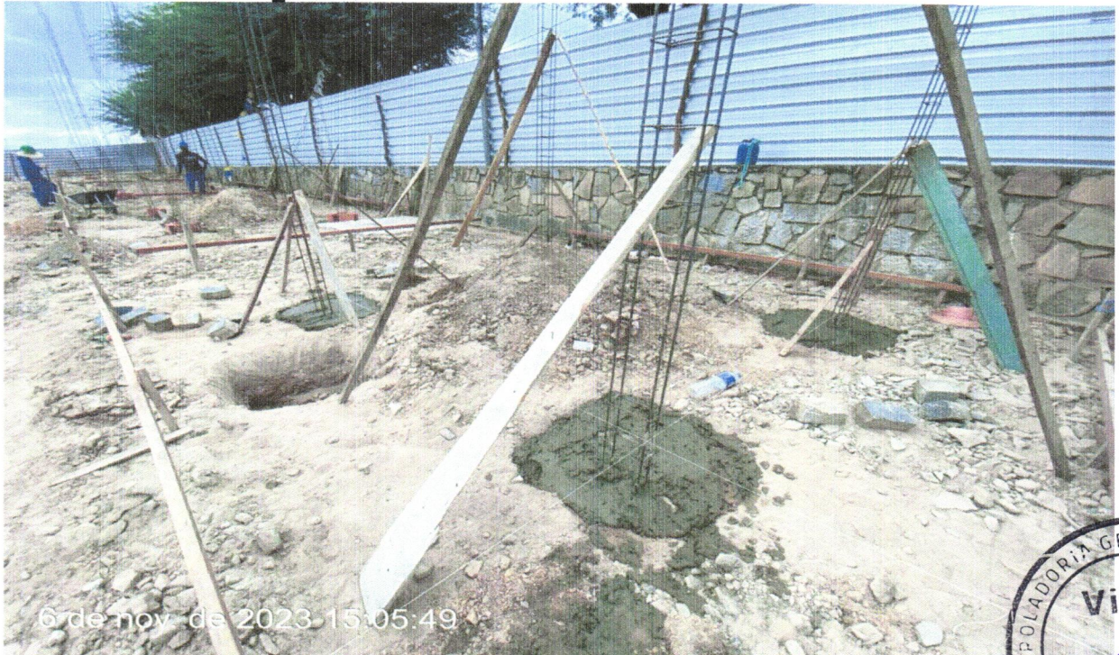
FOTO 52 - LASTRO DE CONCRETO MAGRO, APLICADO EM BLOCOS DE COROAMENTO OU SAPATAS, ESPESSURA DE 3 CM. AF_08/2017.
