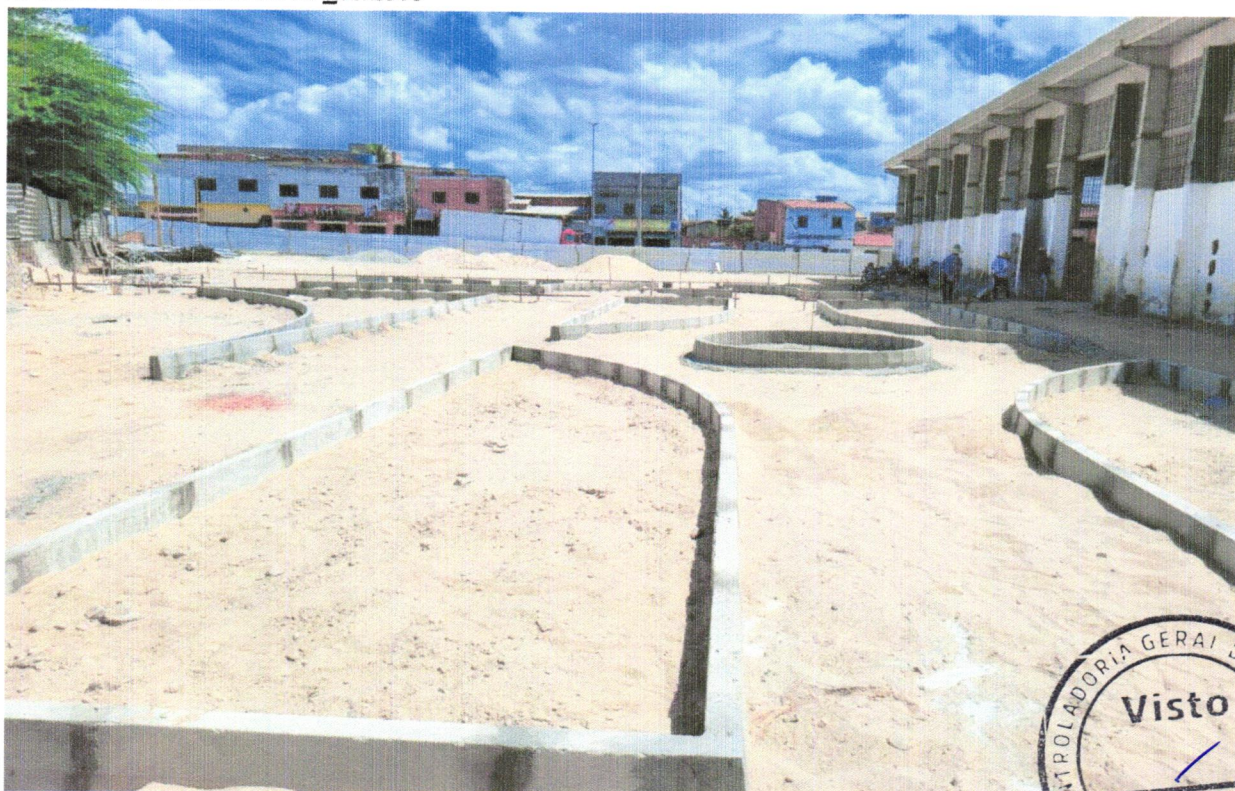
FOTO 68 - GUIA (MEIO-FIO) CONCRETO, MOLDADA IN LOCO EM TRECHO RETO COM EXTRUSORA, 15 CM BASE X 30 CM ALTURA. AF_06/2016
