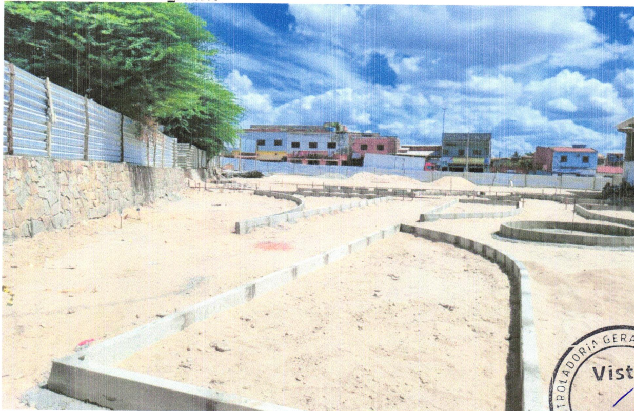
FOTO 70 - GUIA (MEIO-FIO) CONCRETO, MOLDADA IN LOCO EM TRECHO RETO COM EXTRUSORA, 15 CM BASE X 30 CM ALTURA. AF_06/2016
